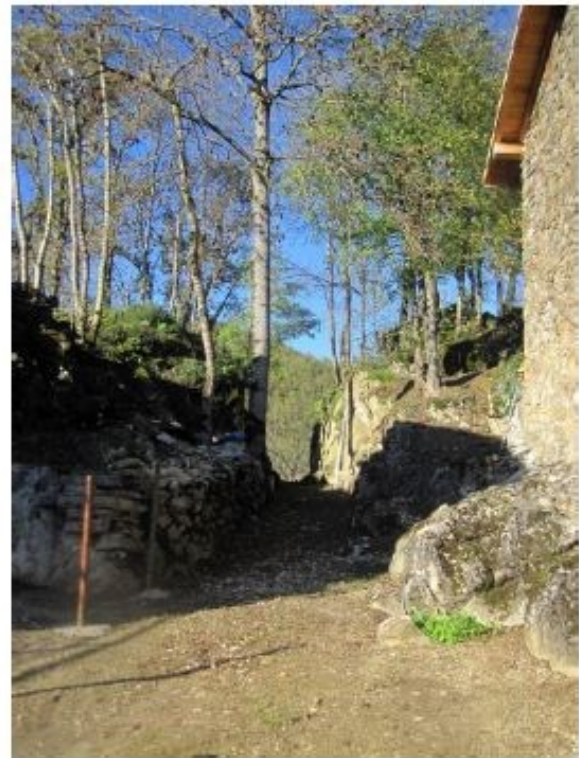
La « faille naturelle » - la tour maitresse est sur la droite de la photo
